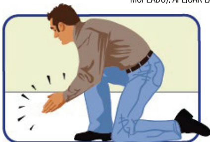
APLICAR LA SIGUIENTE CAPA CON EL PISO SECO. REPETIR TODO HASTA OBTENER EL BRILLO DESEADO.
